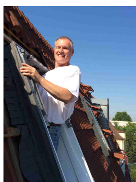
Dachfenstereinbau mit der Holzbau Stopper GmbH aus Nordheim
